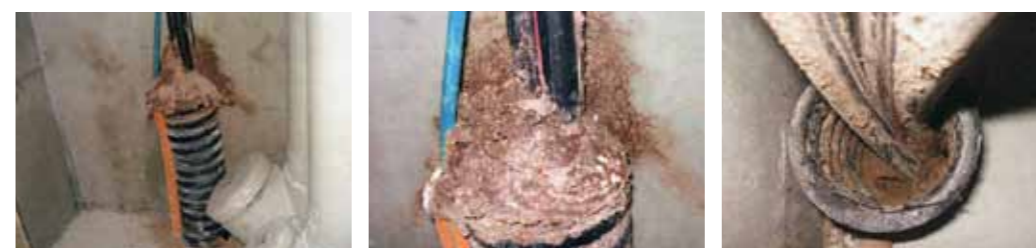
①TV用分電盤 ②蟻土が詰まっているTV用分電盤 ③蟻土撤去後のTV用分電盤 ④分電盤内の蟻道
