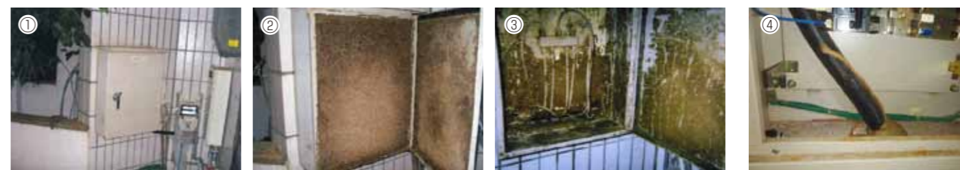
①TV用分電盤 ②蟻土が詰まっているTV用分電盤 ③蟻土撤去後のTV用分電盤 ④分電盤内の蟻道
