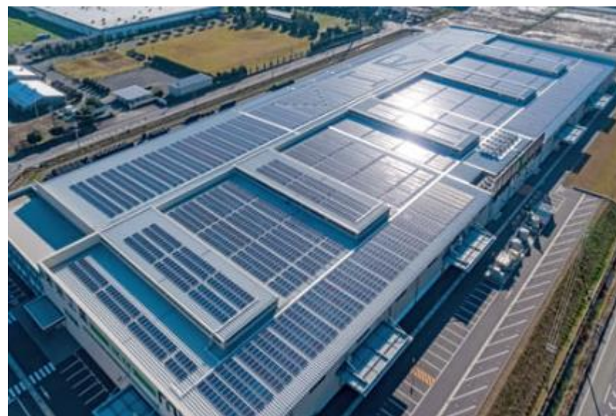
垂井工場(岐阜) 屋根には大規模メガソーラーを設置
