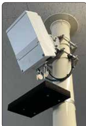
■電磁波アブソーバー取付位置
