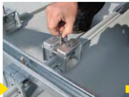
「ハゼ式折板屋根用配管固定金具」施工手順
