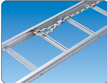
②シャトルロッドの先に牽引ロープを取り付けます。
