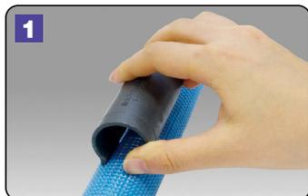
防火キットのスリット部の突起を、配管側面に引っ掛けます。
